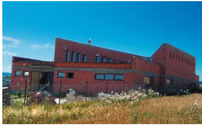
Erste Romakirche in der Slowakei im Rohbau
